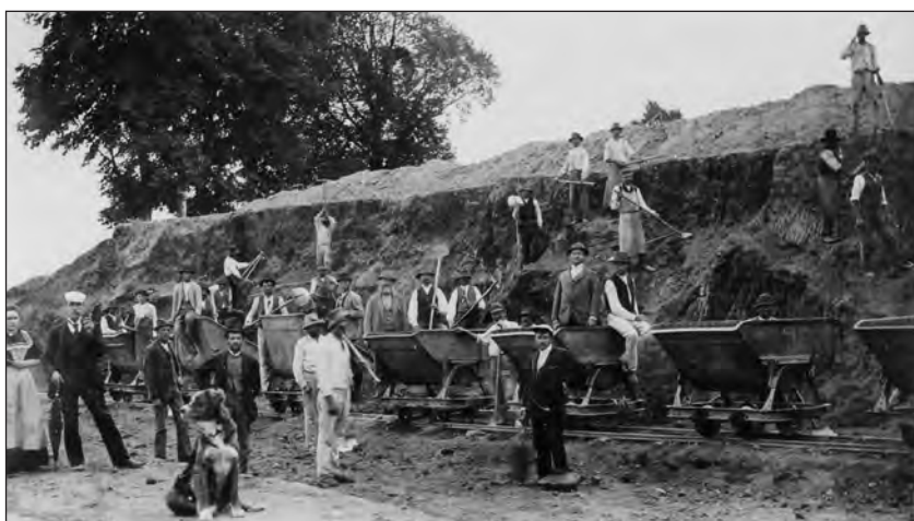
Úprava terénu stráně poblíž železničního přejezdu u nádraží v Postupicích.
