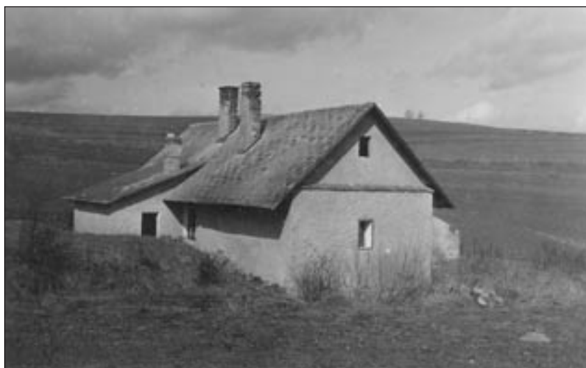
Budova bývalé sušárny nad Postupicemi.
